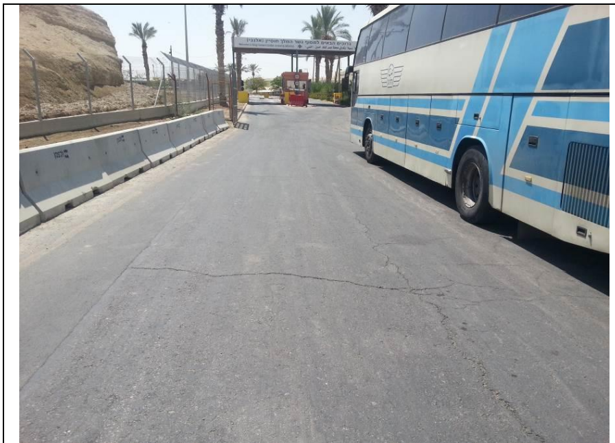
כביש הכניסה למסוף: סדקי בלוק בחומרות שונות, נזקי בלייה והתפוררות
